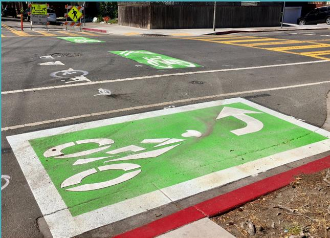
Se trata de una caja de giro de dos etapas, que también permite a un ciclista realizar un giro a la izquierda en dos movimientos sin tener que incorporarse a un carril de giro central, pero sin la separación física de una intersección protegida.
